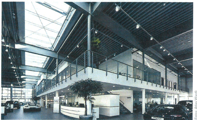
Bild 3 Im Inneren wurde das Stahlhallengerüst an einen massiven Betonkern angeschlossen. Dabei gründen die Innenstützen auf verschiedenen Niveaus, etwa auf hochgelagerten Galerieebenen.
