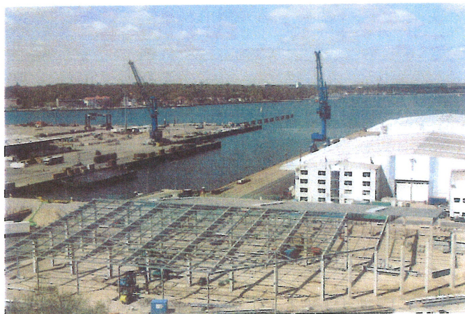
Bild 2. Atlas Ward lieferte die komplexe Stahlkonstruktion, die auf den Betonstützen der Lagerhalle ruht. Schuppen 8 am Seehafen Kiel wurde in nur sechs Monaten aufgebaut. (Fotos: Atlas Ward)
