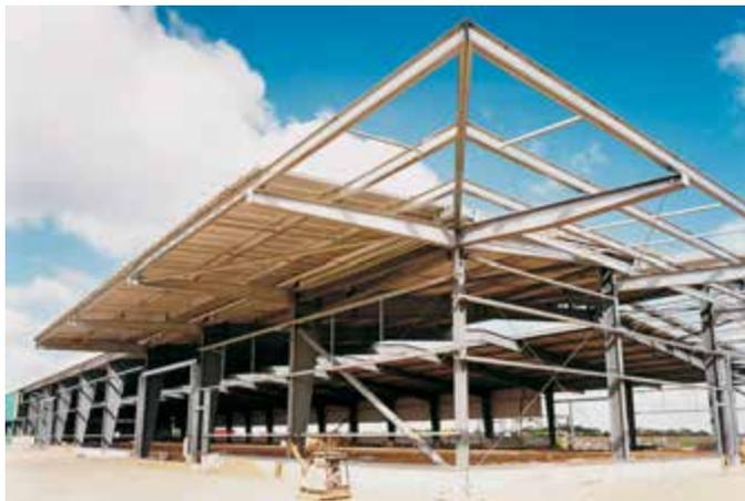
Beim Hallenbau spielt die Tragkonstruktion die tragende Rolle. Sie ist bestimmend für die Flexibilität in der Nutzung und Gestaltung. Fast jede Höhe, Breite und Länge ist möglich. Ihre wirtschaftliche Dimensionierung und statische Berechnung wird für jedes Bauvorhaben mit Unterstützung des Computers und eines eigenen, individuellen Planungs- und Optimierungsprogramms erstellt.
