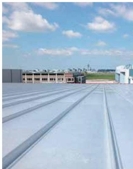
Dach ist noch lange nicht Dach. Und weil Dächer immer unterschiedlichen Ansprüchen genügen müssen, gibt's bei ATLAS gleich drei Dachsysteme. Zum einen das ATLAS-Clad-Dach mit den trapezförmig profilierten Paneelen, das auf der Unterkonstruktion absolut dicht verschraubt wird. Umgekehrt montiert ist es auch für Folien- und Gründächer geeignet.
